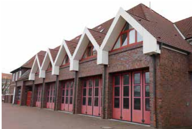
Die in den 80er Jahren gebaute Fahrzeughalle der Feuerwache setzt der lichten Höhe der Fahrzeuge enge Grenzen
